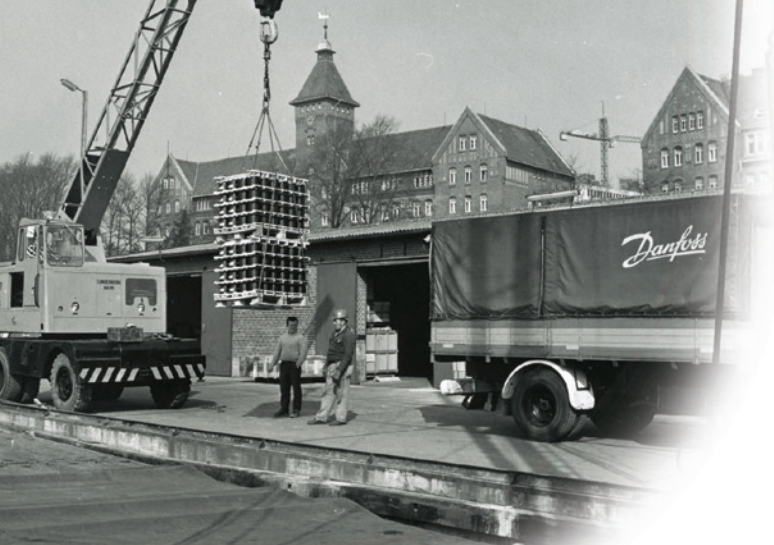
Danfoss-kompressorer lastes med kran til skib.
