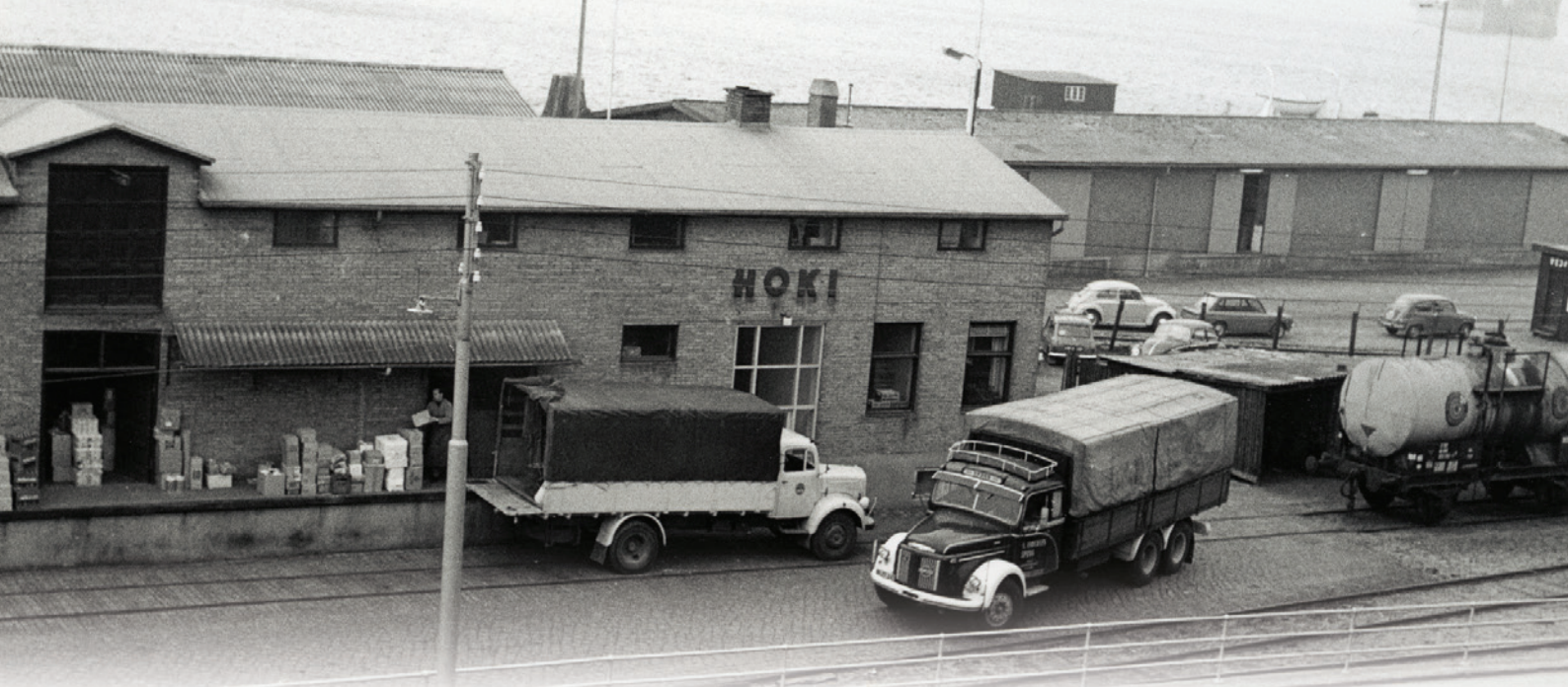
HOKI-bygningen blev senere toldkontor og fungerede til sidst som HKS-lager indtil den for et par år siden blev revet ned og et nyt lager opført samme sted.
