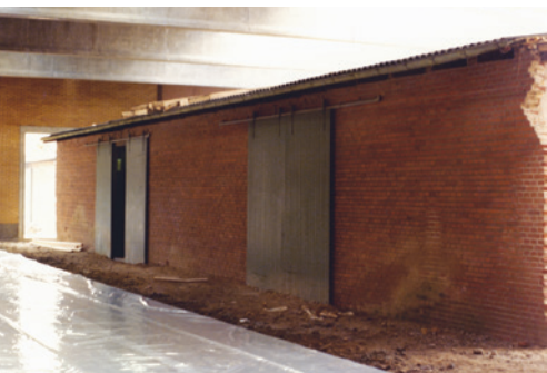
Imens det gamle pakhus var i drift blev der udvidet "hen over hovedet" af det gamle.
